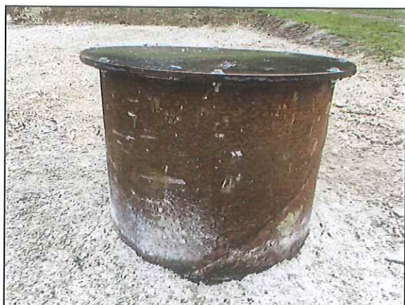
Tête du forage avec capot
