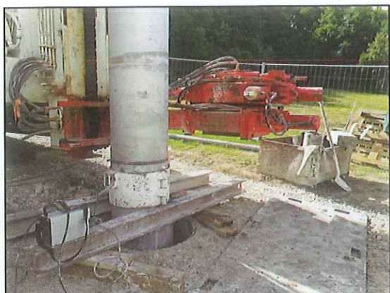
Mise en place du tube plein
