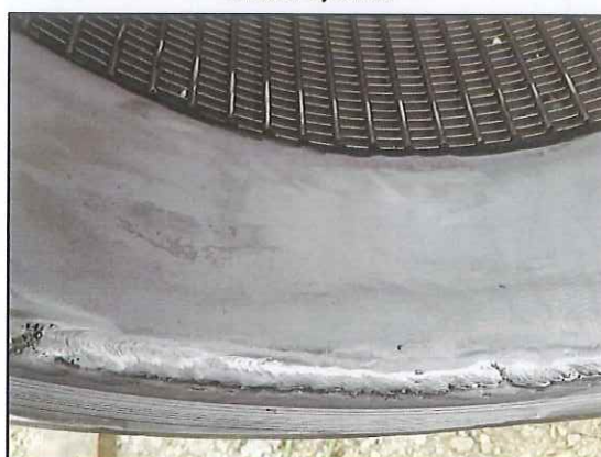
Tube crépiné endommagé, après réparation
