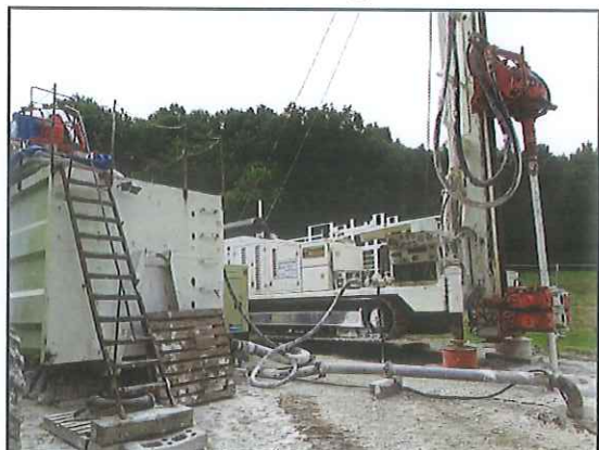
Foration de l'aquifère en diamètre 445 mm
