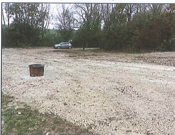
Site après repli de l'entreprise
