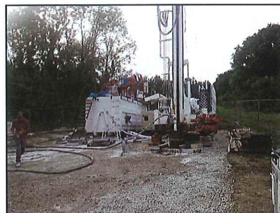
Cimentation à l'extrados du tubage acier
