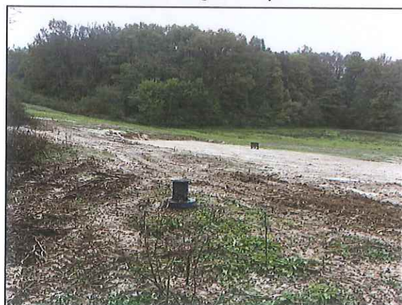
Site après repli de l'entreprise
